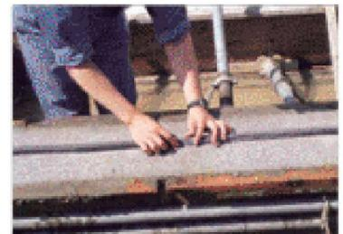
接合部は突合せとし、指でならし一体化させます。クニシールC-31とコンクリートの境界面が乾燥した後、コンクリートへ強固に付着していることを確認してから二次コンクリートを打設してください。
