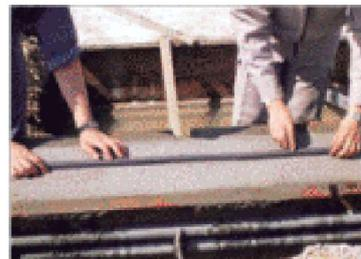
設置面が乾燥する前にクニシールC-31をケースから両手で取り出し、設置面へしっかりと押し付けます。この際、形状が崩れても構いませんので、手でよく圧着して隙間のないように接着させてください。
